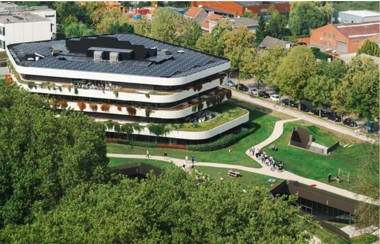
De verschillende gebouwen van Howest aan het Magdalenapark zijn al onderling verbonden via een intern warmtenet. © Howest
