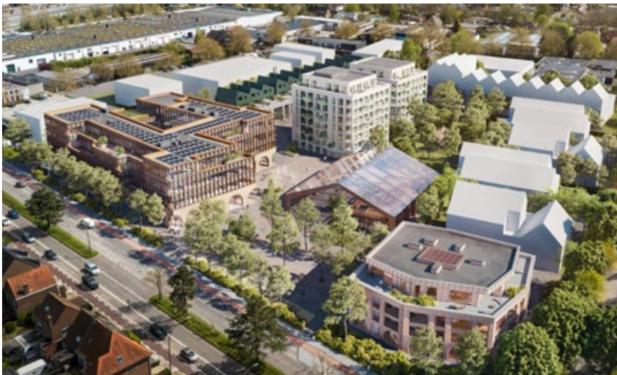
In totaal zal BULA goed zijn voor 37.500 boormeters, verdeeld over 250 boringen tot 150 meter diep. © Global Estate Group
